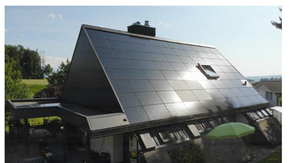
Abbildung 5: Beispiel einer Blendsanierung. Vier Module sind mit satiniertem Glas bestückt, die restlichen Module mit Standard-Solarglas.
